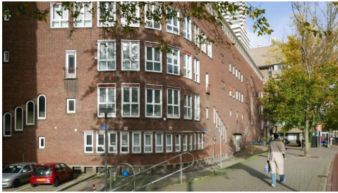
Verplaatsing GGD en SB van Schiedamsedijk naar Zalmstraat 7
