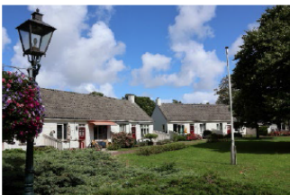
In het Willemshof kan met een goed ontwerp een redelijk groot dak worden gebruikt om zonne-energie op te wekken
