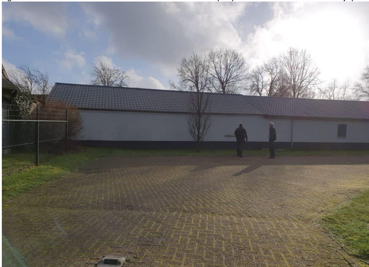
Figuur 4. Achterkant te slopen pand met rechts aangrenzend te behouden bedrijfspand.
