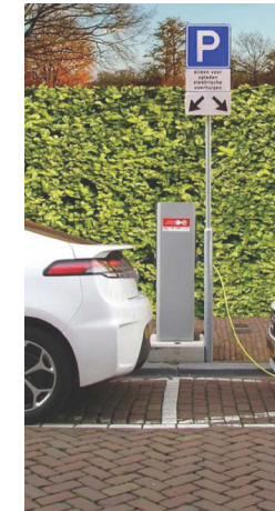
Laadpaal t.b.v. elektrische auto's
