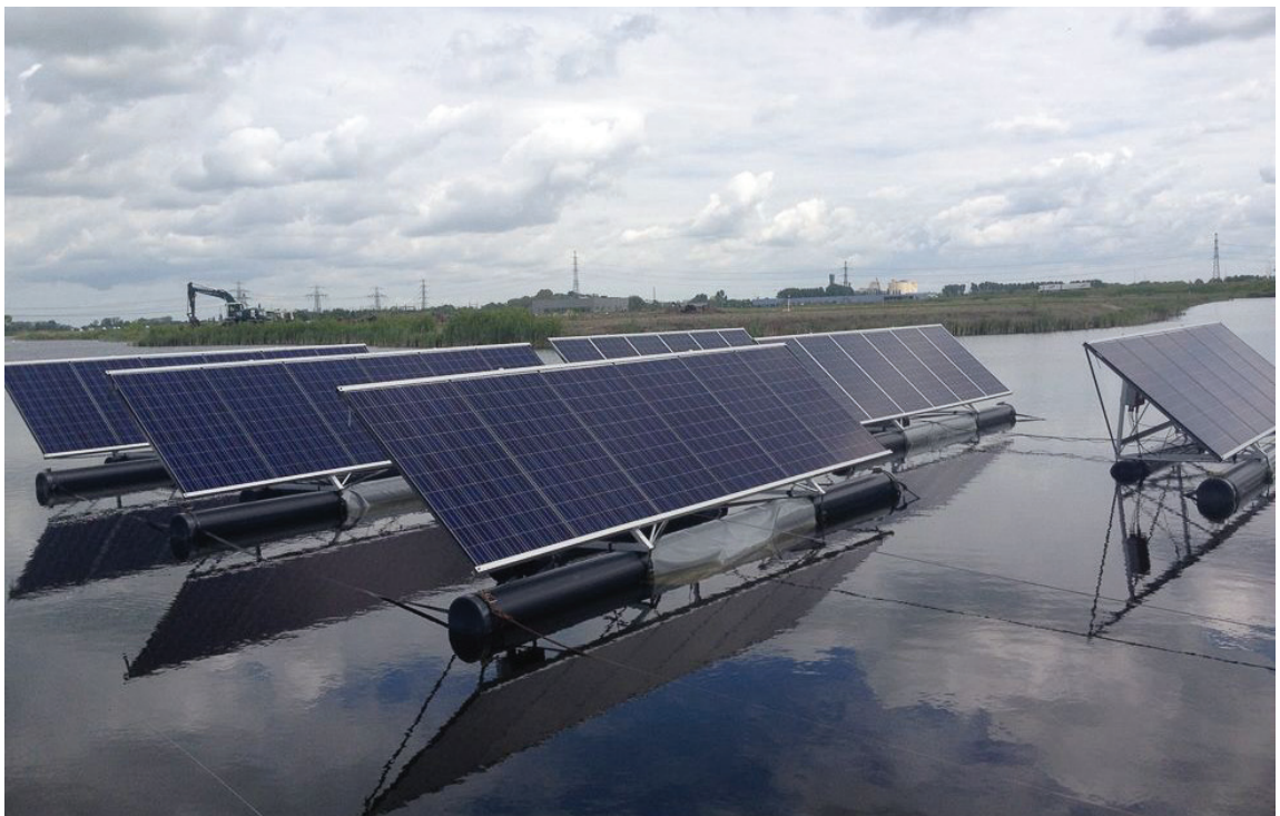
Voorbeeld drijvend zonnepark op de Slufter (beeld Rijkswaterstaat)
