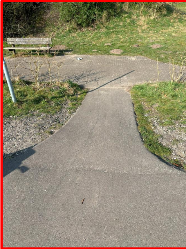
Een te steile toegang voor rolstoelgebruikers
