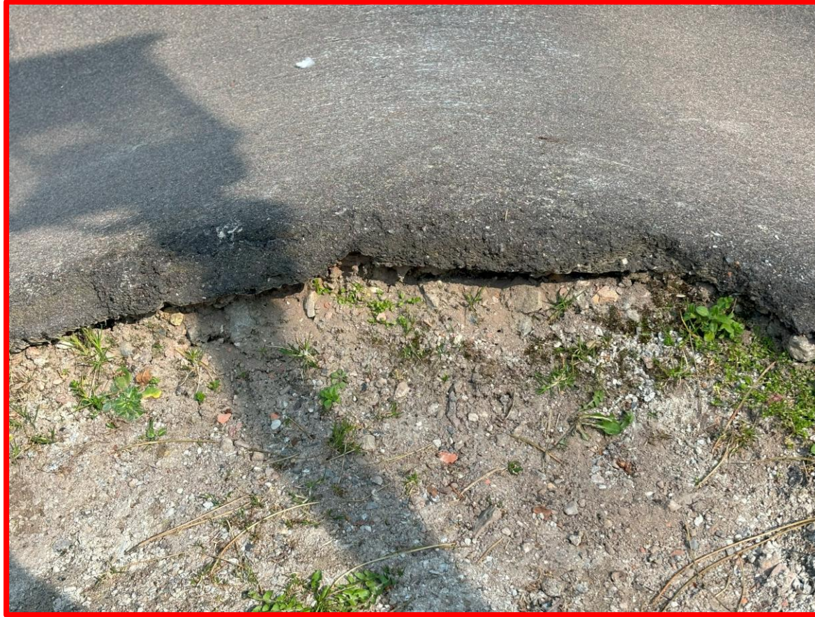
Geen zwevend asfalt, gedegen grondwerk
