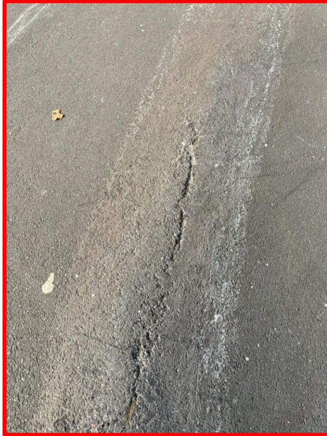
Voorkomen van scheurend asfalt
