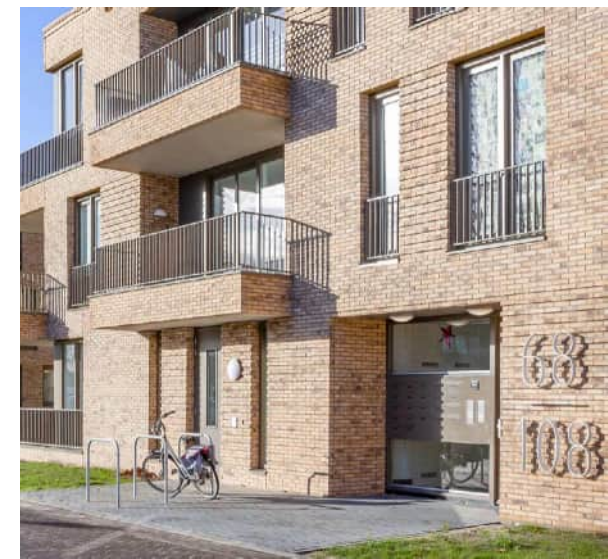
Balkons hangen niet aan de gevel, maar worden deels opgelost in het blok, waardoor meer interactie is met de woonkamer en mensen er beschut kunnen zitten (met de uitzondering voor de balkons op de zuidzijde van het bouwblok vanwege ligging op de zon).
