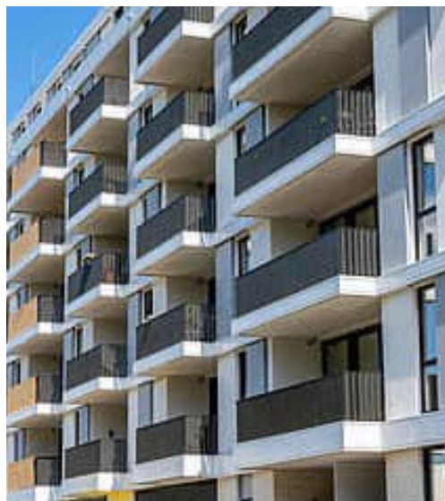
Balkons hangen niet aan de gevel, maar worden deels opgelost in het blok, waardoor meer interactie is met de woonkamer en mensen er beschut kunnen zitten (met de uitzondering voor de balkons op de zuidzijde van het bouwblok vanwege ligging op de zon).
