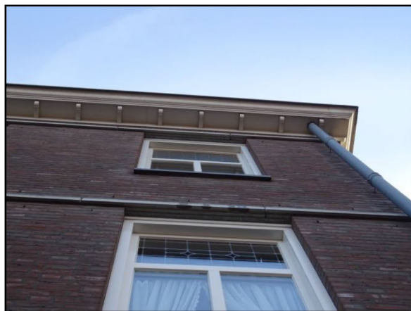
Figuur 11. Boeiboord biedt potentiële verblijfplaatsen voor gierzwaluwen en vleermuizen.
