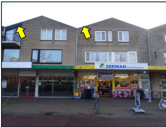
Figuur 12. Potentiele verblijfplaats voor gebouwbewonende vleermuizen in de spouwmuur, achter betimmering en onder de dakrand.
