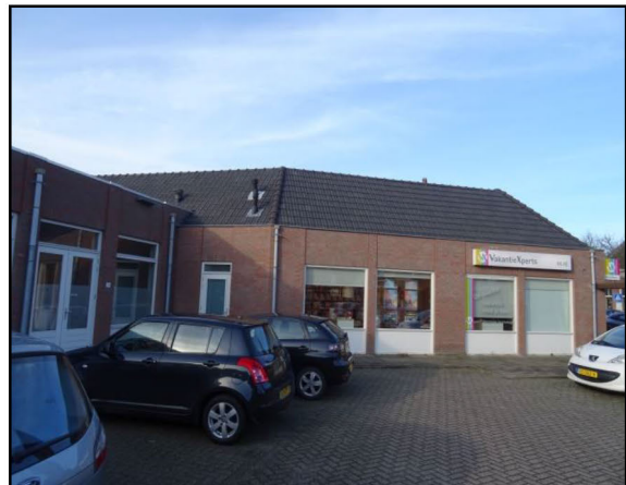
Figuur 10. Dakgoot biedt toegang tot onder het dak voor huismussen.
