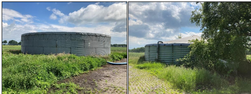
Figuur 2.19 (links): De noordelijke mestsilo; Figuur 2.20 (rechts): De zuidelijk mestsilo.
