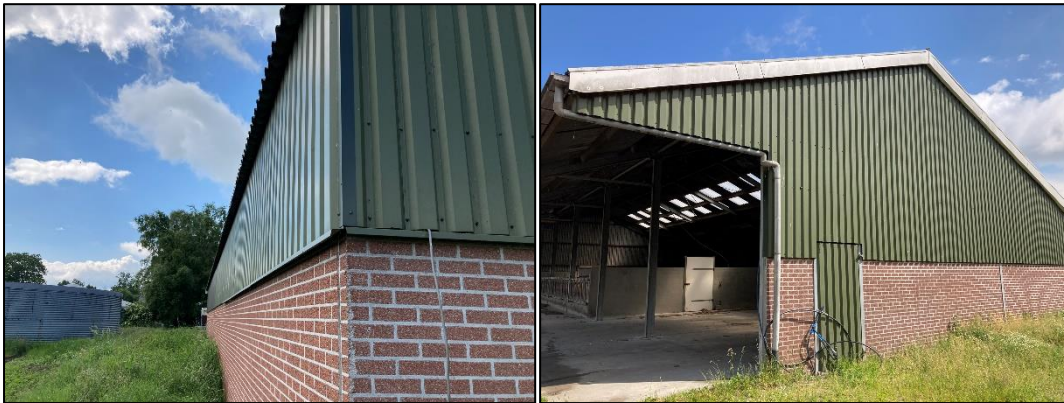
Figuur 2.9 (links): De oostzijde van de jongveestal bestaat uit een gemetselde muur met damwand; Figuur 2.10 (rechts): De zuidzijde van de stal.
