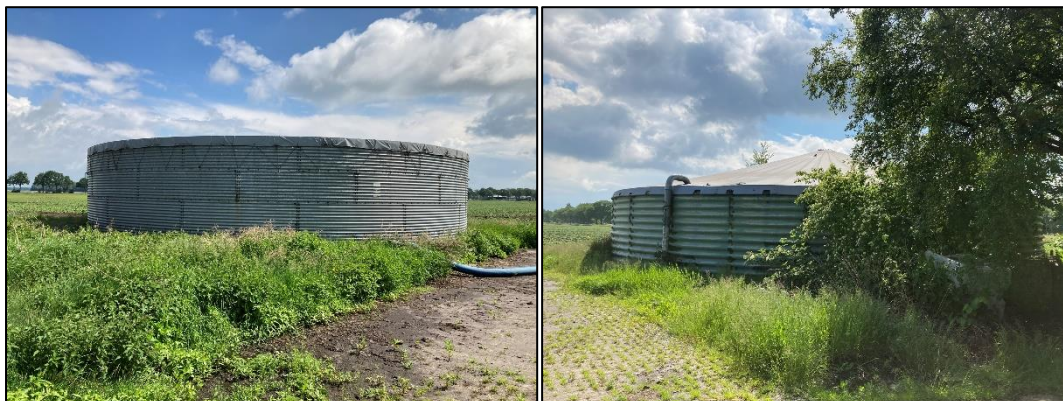
Figuur 2.19 (links): De noordelijke mestsilo; Figuur 2.20 (rechts): De zuidelijk mestsilo.
