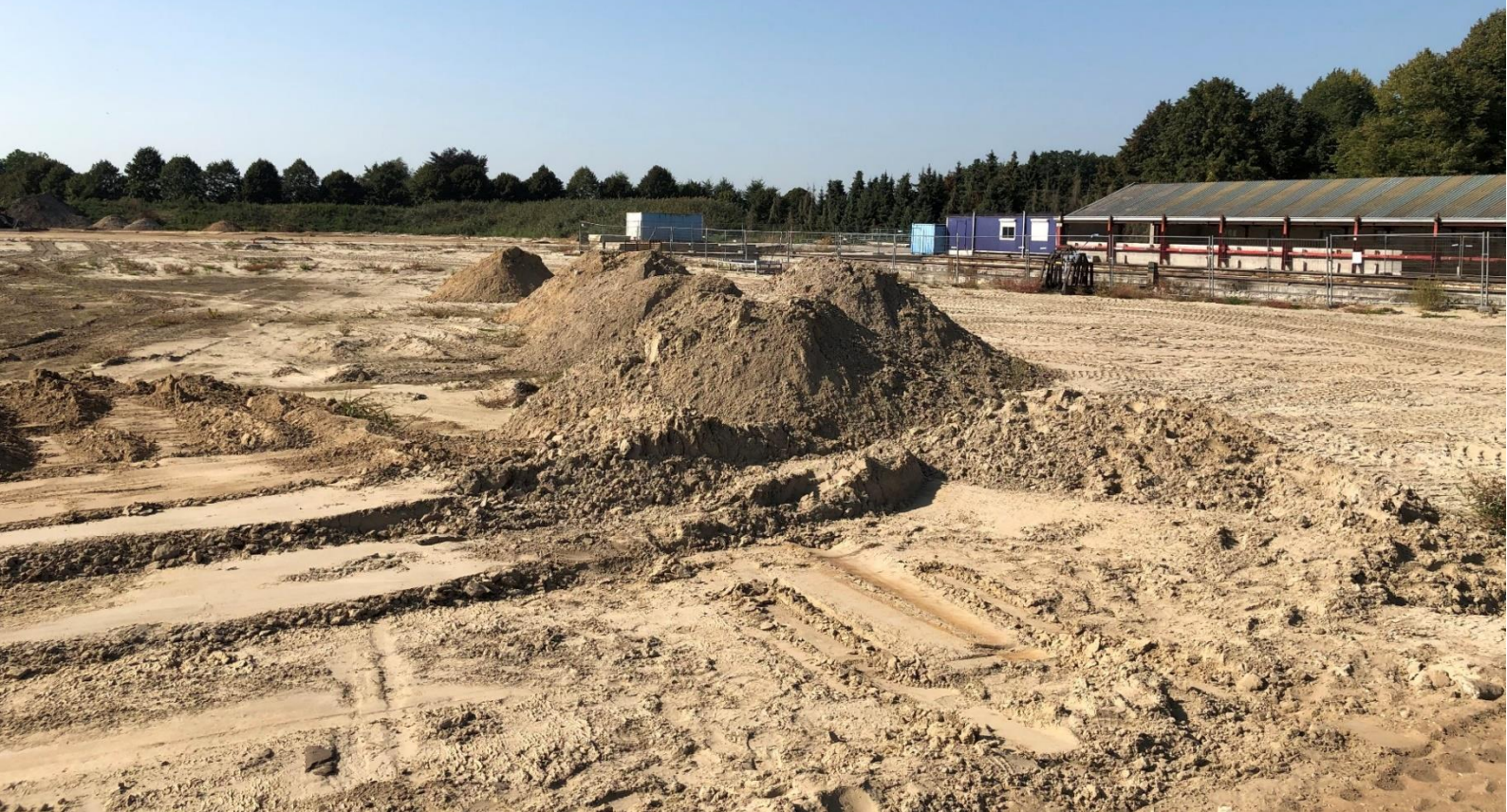
Afbeelding: Grondwerkzaamheden ten behoeve van zonnenveld 'De Branderwal' bij Kootwijkerbroek.
