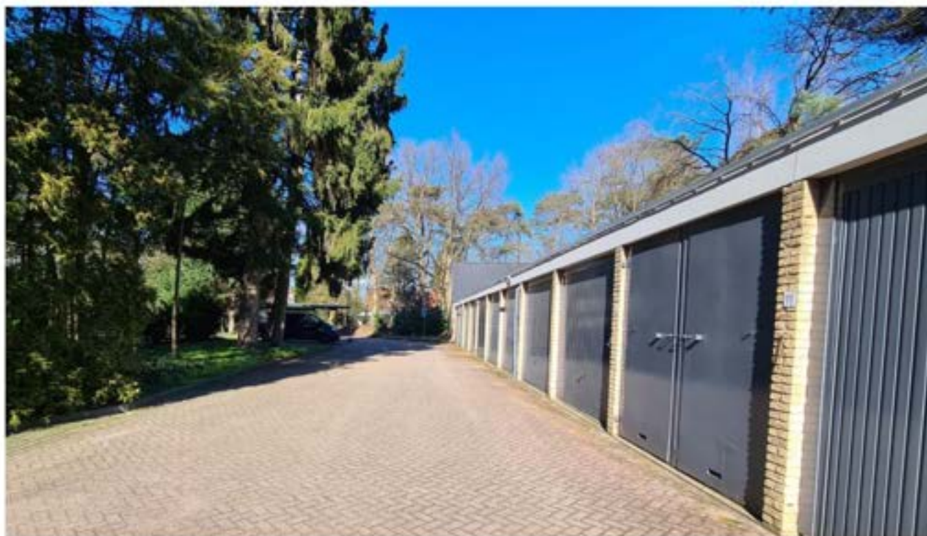
Figuur 1: Garageboxen gezien vanuit het noorden
