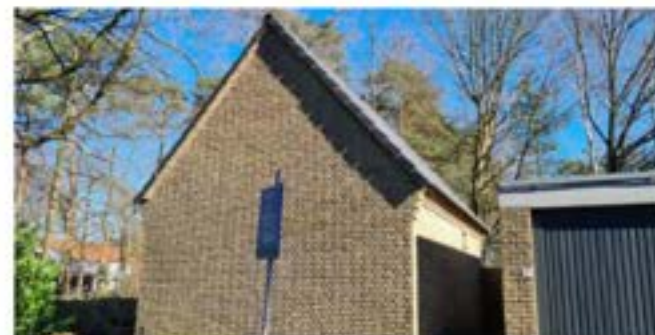
Figuur 6: Elektriciteitsgebouw ten noorden van garageboxen
