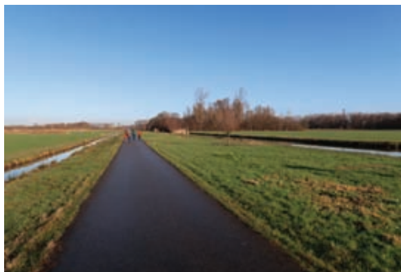
Fietspad, gezien richting eendenkooi (19)
