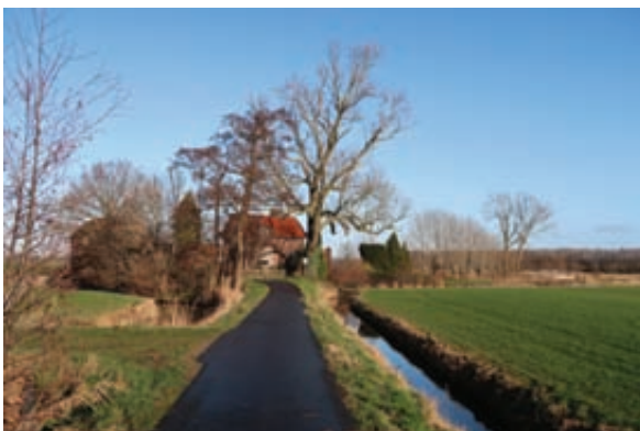
Gemaal met dienstwoning aan het eind van de kade (15).
