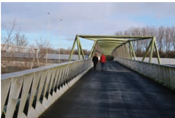
Viaduct voor langzaam verkeer over de A2 (19).
