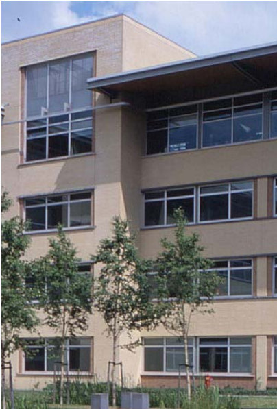
Setbacks articuleren de massa en versterken de plasticiteit. Een doorlopende geveltaal bindt de bouwdelen tot een sculpturaal geheel.
