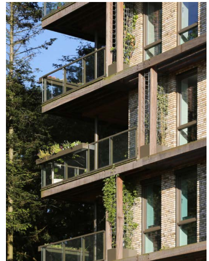
Raamwerk van bijpassend materiaal geeft gelaagdheid. Veluwe Proeftuin / WFC, Ede (MIX architectuur)
