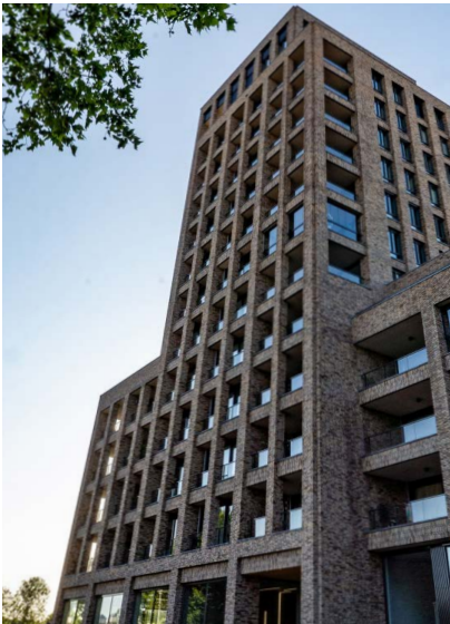
Hoogbouw in duidelijk grid en eenheid van materiaal, maar met setback en teruglegging. Eureka, Breda (MIX)
