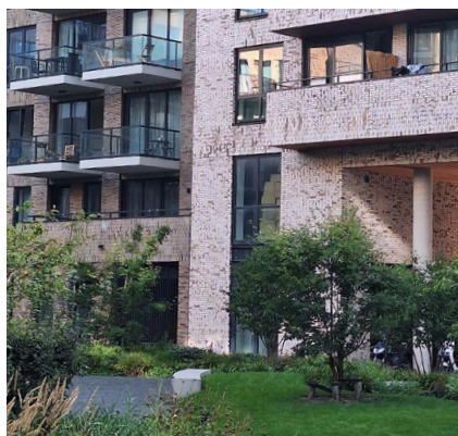
Bestaande bebouwing en nieuwbouw vormen eenheid door kleurgebruik en orthogonale gevelindeling. Gortercomplex, Leiden (GROUP A)
