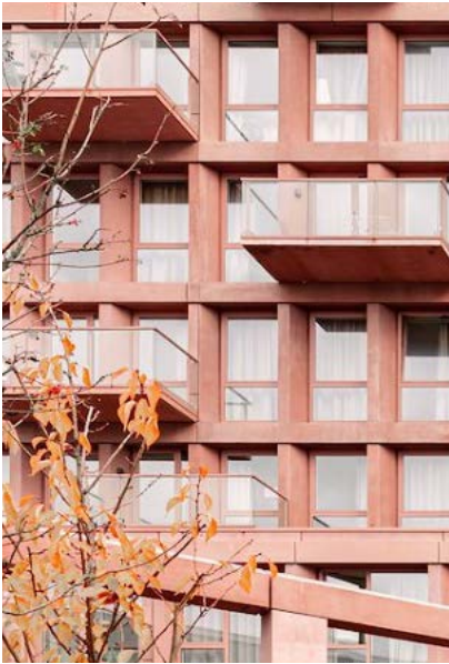
Balkons zijn onderdeel van de gevelstructuur en liggen binnen de rooilijn. Highnote, Almere (Studio Ninedots).
