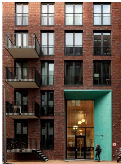
Zichtbare entree door kleur, teruglegging en transparantie. Strijp S, Eindhoven (Orange architects)
