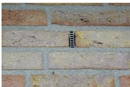
Afbeelding 18: stootvoegen afgesloten met bijenbekjes. Bron: BNL Advies. Datum: 11-11-2021
