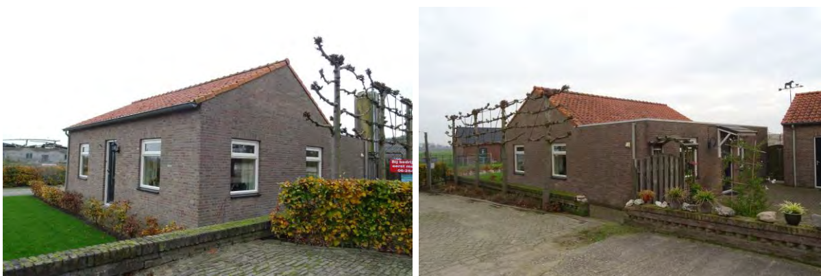
Afbeelding 9 en 10: Bestaande te slopen bedrijfswoning met bijgebouw op de kavel. Bron: BNL advies 11-11-2021
