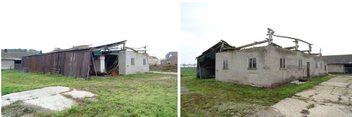
Afbeelding 7 en 8: Bestaande te slopen bijgebouw op de kavel. Bron: BNL advies 11-11-2021
