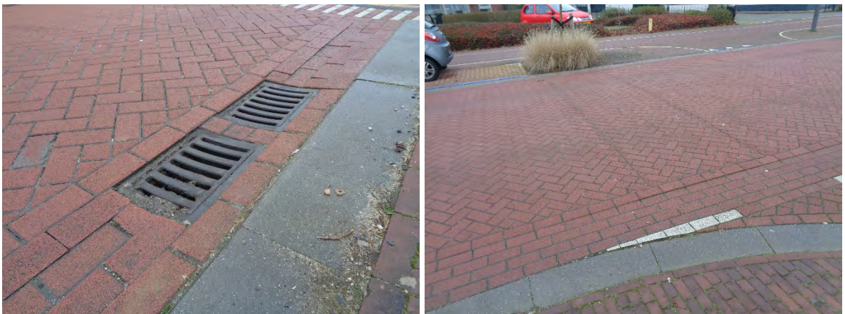
Figuur 2-9: enkele oneffenheden en putdeksels situatie rafeling / kleine gaten
