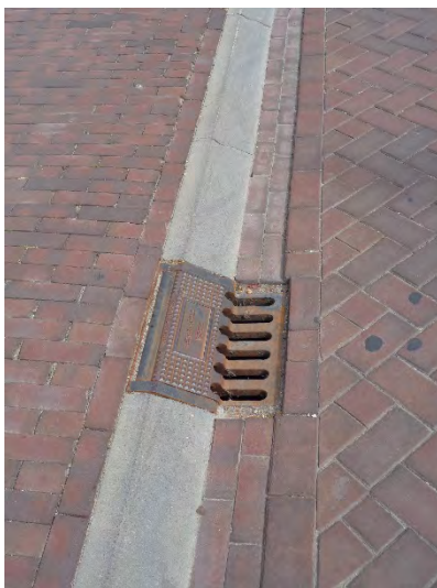
Figuur 6-2: Kolk deels in stoepband
