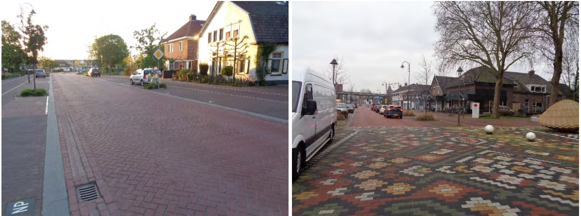
Figuur 2-7: Wegsituatie rondom Dorpstraat 112, enkele oneffenheden en putdeksels
