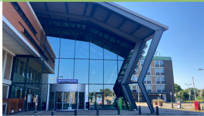
Zicht op de bestaande entreehal
