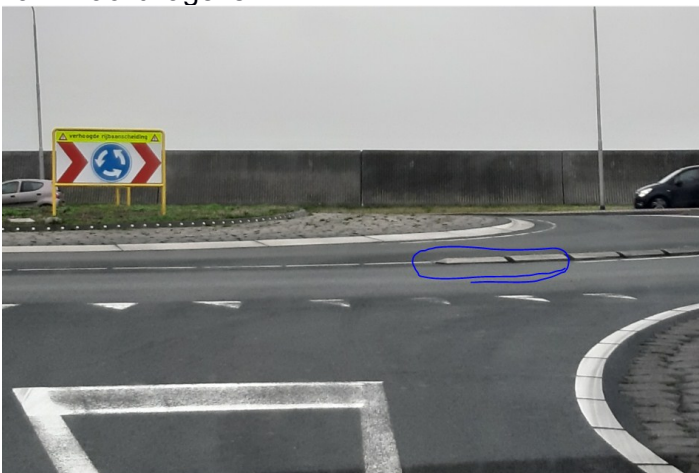
Afbeelding 3: de betonnen afzetting op de rotonde welke ten koste gaat van de autobanden van vrachtwagens.
