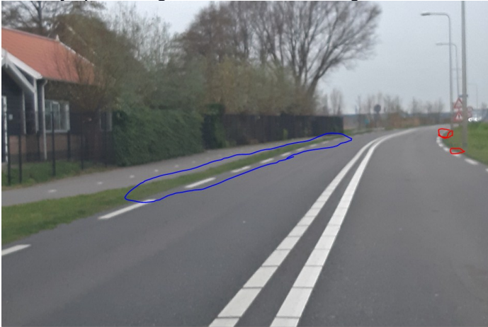
Afbeelding 1 (weg ligt zonder afscheiding te dicht op fiets-/wandelpad en lantaarns staan te dichtbij op de weg waardoor vrachtwagens in de bocht moeten uitwijken)
