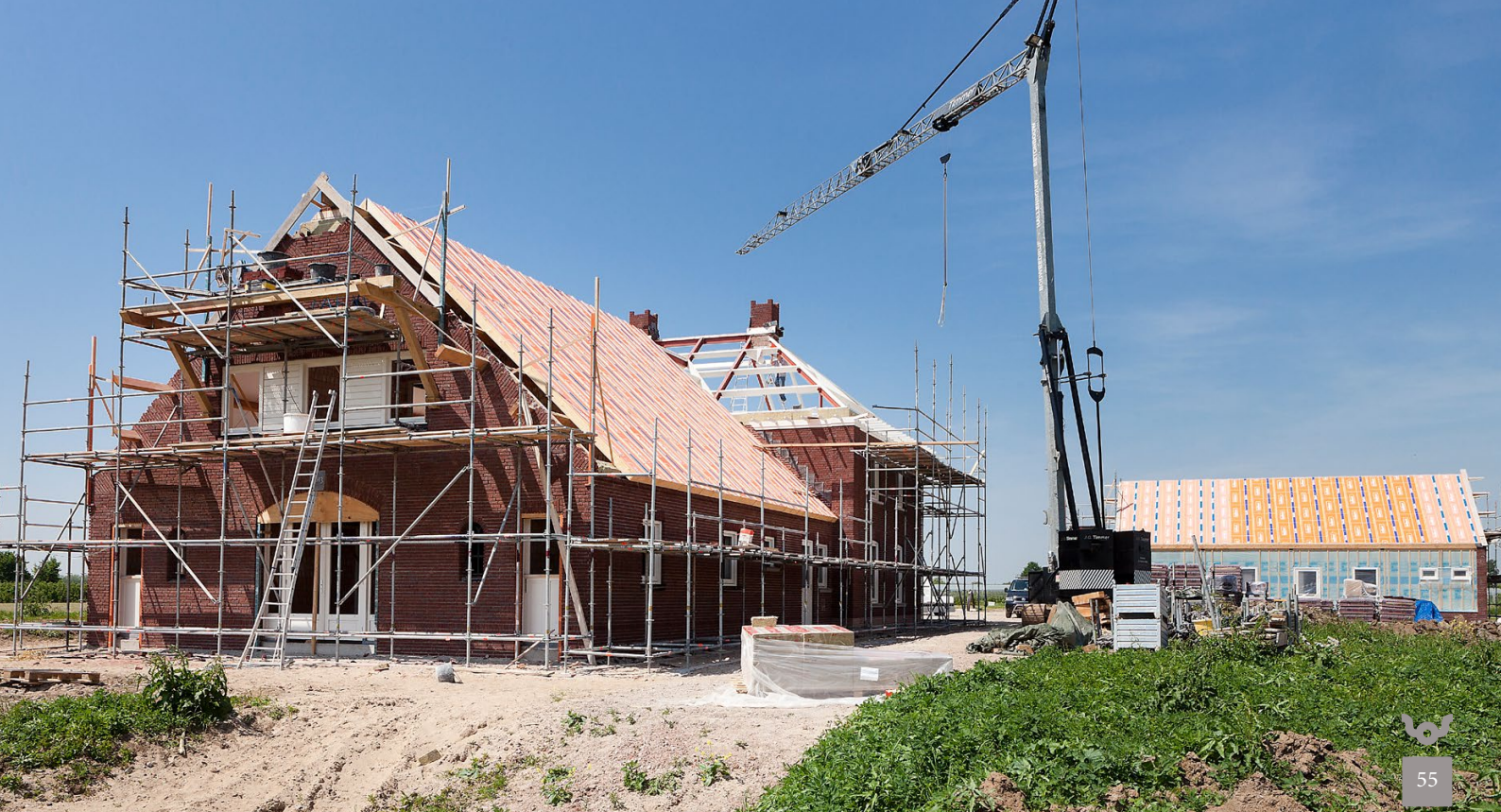
Afbeelding 24. Nieuwbouw in aanbouw.
