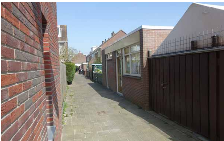
Figuur 19 - Achterpaden bungalows
