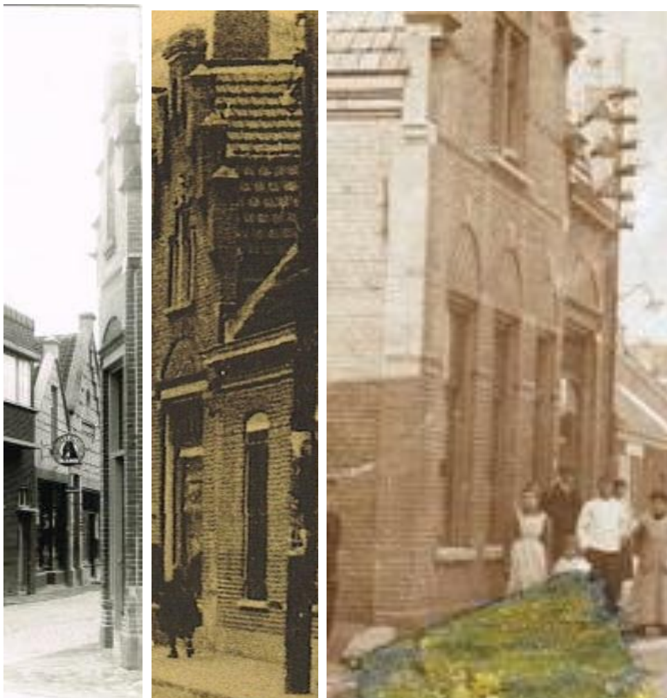
Details van historische foto's waaruit met name het oorspronkelijke aanzien van het gebouw is te achterhalen. Twee trapgevels die het pand gesierd hebben, zijn lang geleden al verdwenen.
