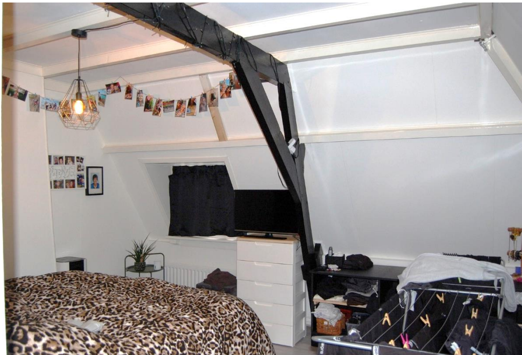
Deel van het volledige spant haaks op de voorgevel op de zolder van nummer 3.
