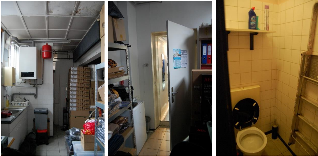
De begane grond met het magazijn waarin elementen en afwerkingen uit de jaren zestig en later te vinden zijn.
