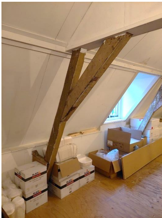
Spantbeen en korbeel aan de straatzijde (links) en secundaire stijl onder de dekbalk aan de achterzijde van het pand.
