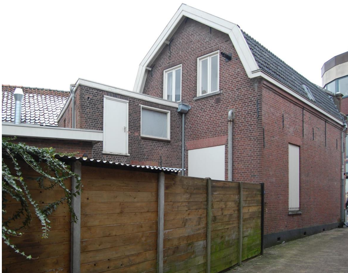
De zijgevel en achtergevel van het pand zijn uiterst eenvoudig in opzet en detaillering.
