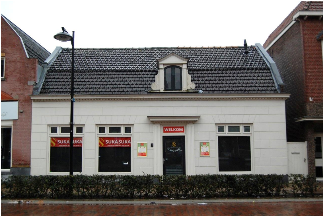
De gevelopzet is nog oorspronkelijk, de vormgeving en de gevelelementen zijn van betrekkelijk recente datum.
