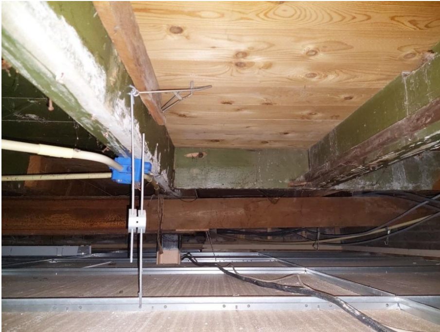
De balklaag van de zoldervloer. Tussen balklaag en systeemplafond de ligger van het stalen portaalspant.
