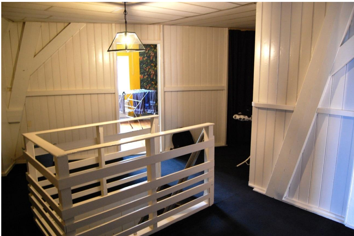
Op de zolder zijn wanden getimmerd met kraaldelen, wat op een oorsprong vóór circa 1925 wijst. De spantbenen, korbeels en blokkeels van de kapconstructie zijn op de foto in het zicht.
