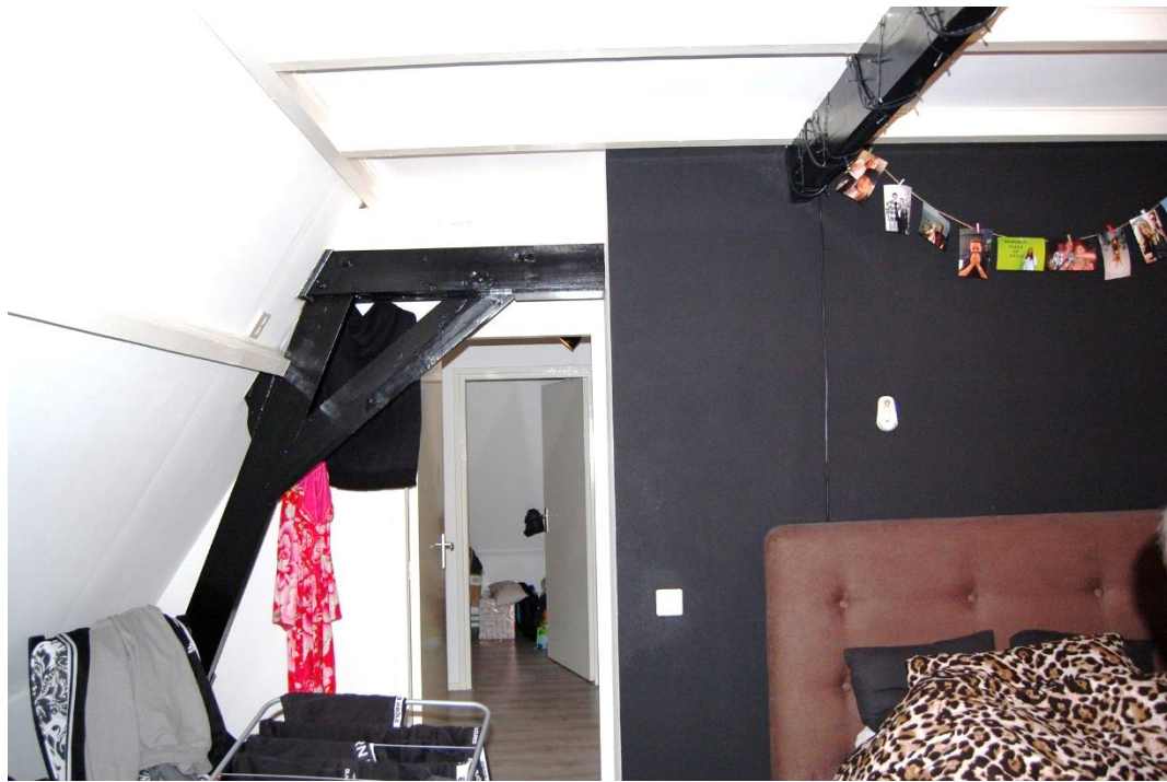
Deel van het halve spant evenwijdig aan op de voorgevel (voorgevel in de rug) op de zolder van nummer 3.
