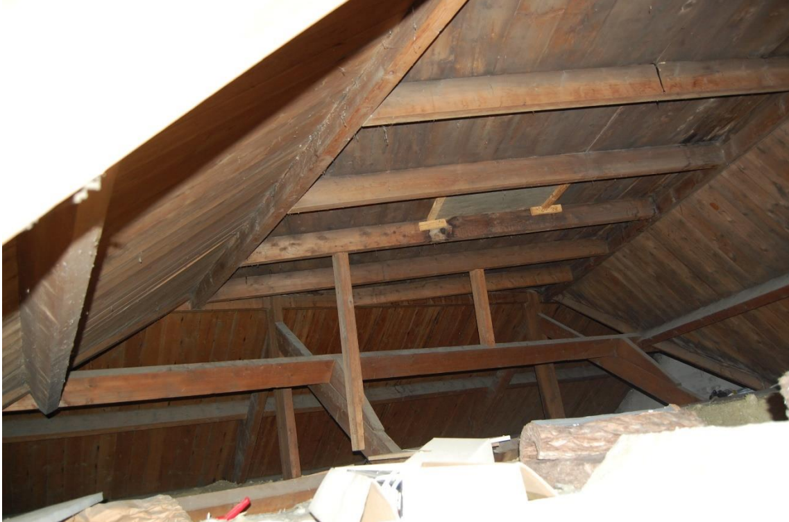
Een deel van de kapconstructie van het huis. De camera wordt vanaf de overhoekse gevel gericht in de richting van Het Anker. De twee kaspanten met afgeschoorde makelaar/nokstijl zijn te onderscheiden.
