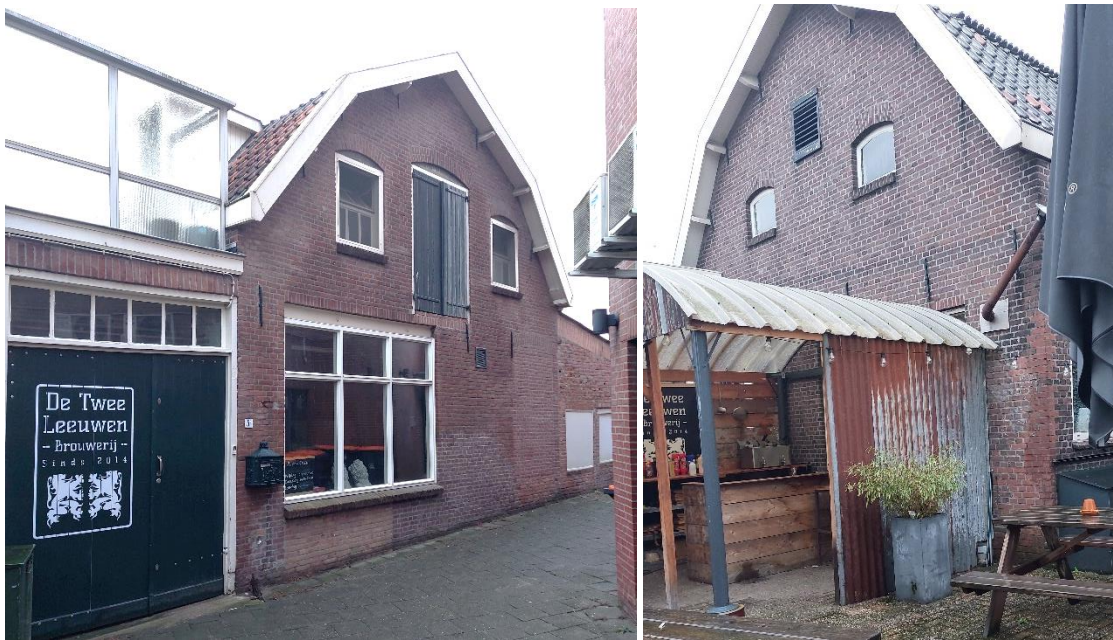
De kopgevels van de voormalige bakkerij.
