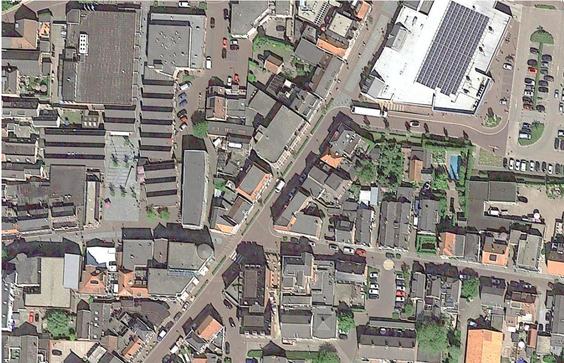
De huidige toestand met linksboven de kruising het onderzoeksgebied, ingesloten door recentere, grootschaligere nieuwbouw.
