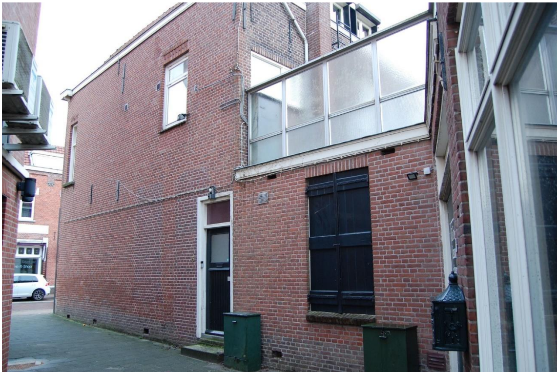
De rechter zijgevel met dichtgezette venster- en deuropening op de begane grond.
