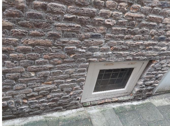
De aangepaste top van de rechter zijgevel. Rechts het ingebroken kelderlicht (ook nog vernieuwd). Ook het toiletvenster is ingebroken in de gevel uit de periode 1815-1832, vrijwel zeker gebeurde dat in 1911.
