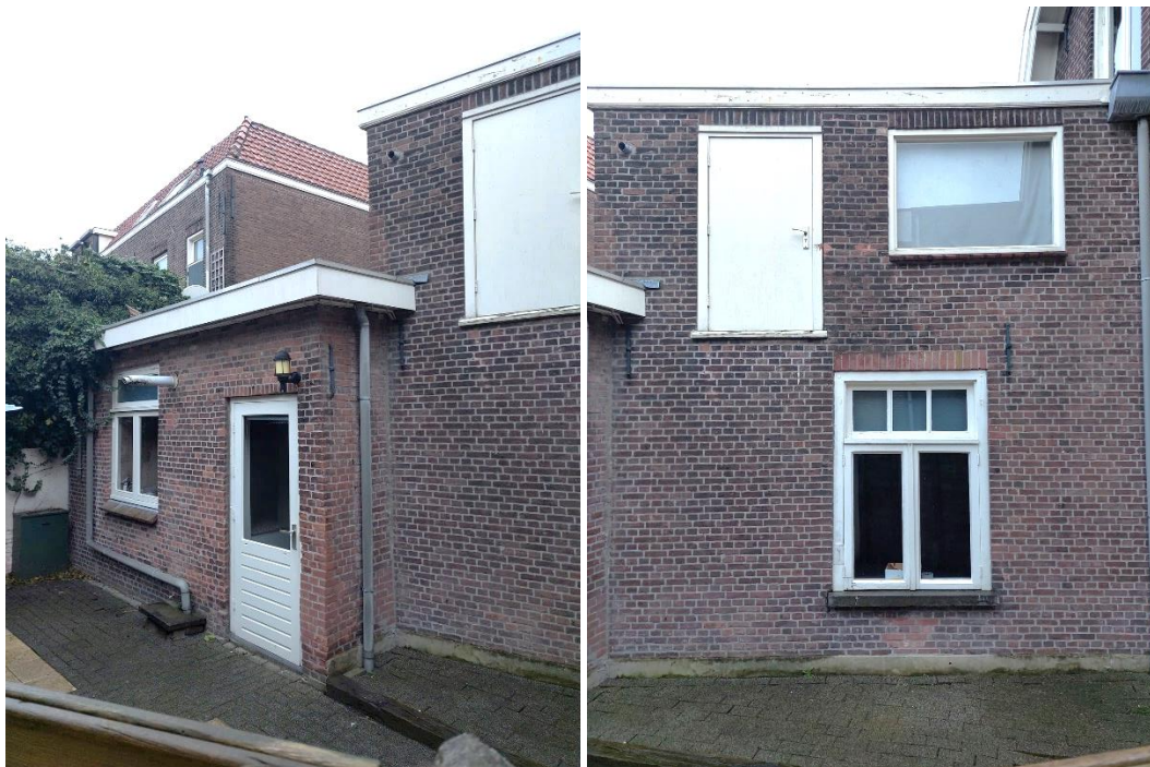
De gevels van de aanbouwen hebben vooral gevelelementen uit de tweede helft van de twintigste eeuw. De achterste aanbouw is in 1941 gerealiseerd.
