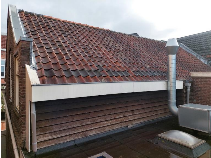
Aan de achterzijde is de mansardevorm verdwenen nadat de achtergevel hogerop werd getrokken. Het platte dak op de voorgrond bevindt zich boven de uitgebouwde keuken op de voormalige binnenplaats.
