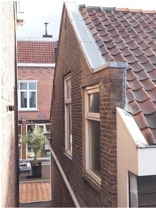
De aangepaste top van de rechter zijgevel. Rechts het ingebroken kelderlicht (ook nog vernieuwd). Ook het toiletvenster is ingebroken in de gevel uit de periode 1815-1832, vrijwel zeker gebeurde dat in 1911.
