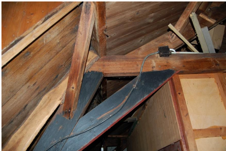
Details van één van de twee spanten boven de voormalige bakkerij. De constructie is nog geheel oorspronkelijk.
