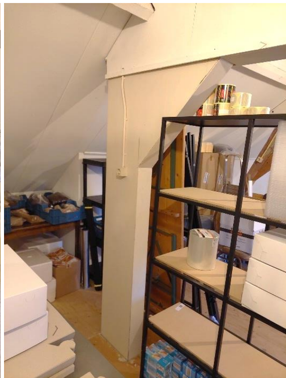
Spantbeen en korbeel aan de straatzijde (links) en secundaire stijl onder de dekbalk aan de achterzijde van het pand.
