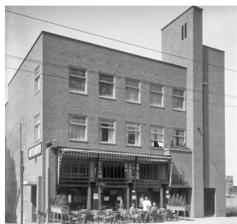
▲ Foto HUA – originele gevels.
