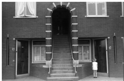
▲ Foto HUA – karakteristieke portiekontsluiting van beneden – en bovenwoningen stationsgebied.
