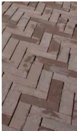
▲ Basisverharding gebakken klinkers.
