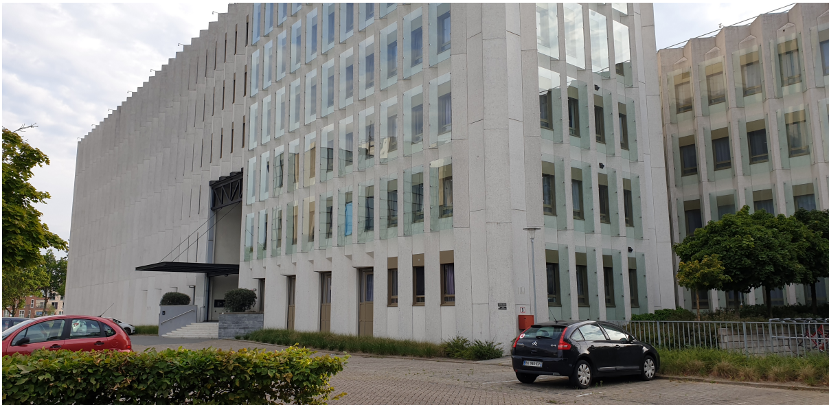
Aanzicht voor- en zijgevel Vliegend Hertlaan 1 vanaf het parkeerterrein (bron: Gemeente Utrecht, 2020)
