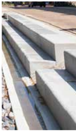
▲ Betonbanden verlaagde groenvakken.
