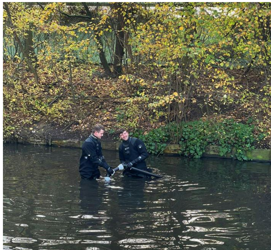
Werkzaamheden herstel persleiding
