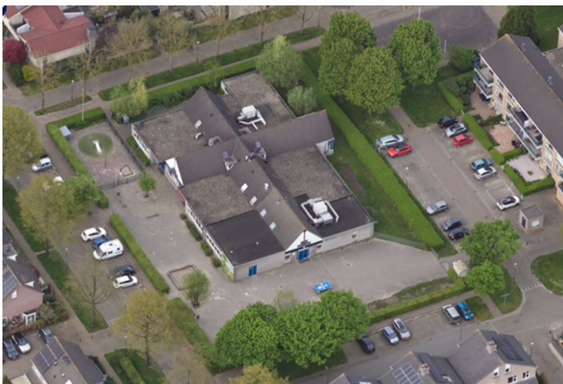
Luchtfoto huidige situatie
