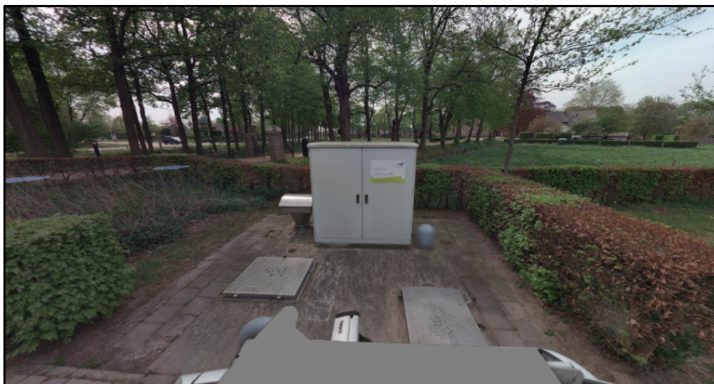
Zijaanzicht van het rioolgemaal met op de achtergrond de oprijlaan naar het kasteel
