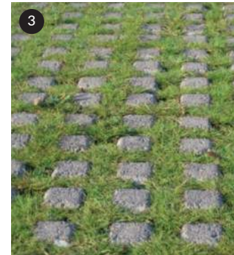
Gras-beton tegels, incl basaltgrind 0-8mm tussen de voegen
