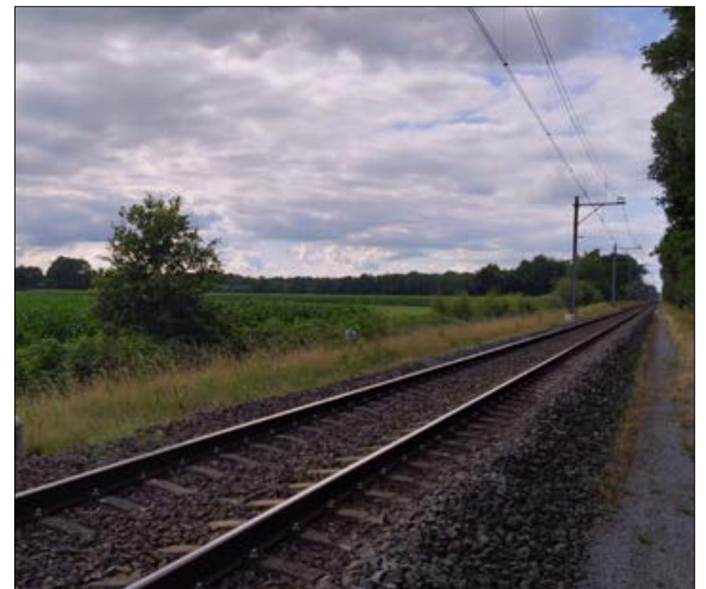
Afbeelding 11: huidige beplanting langs het spoor (Adviesbureau Haver Droeze)
