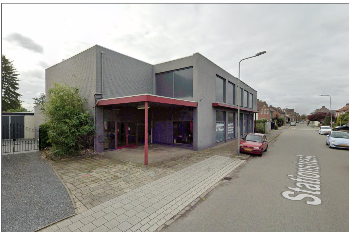
Figuur 5. Straatfoto Stationsstraat 170 Elsloo, gezien vanuit het oosten (bron: maps.google.com, foto oktober 2021).
