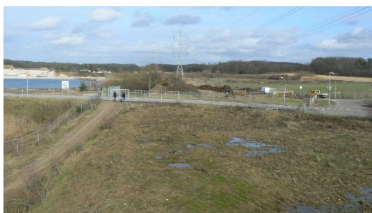
Figuur 20: De huidige aansluiting van het onderhoudspad op de Tegelstraat. Voor het Rondje Groeves wordt de aansluiting naar rechts verplaatst om aan te sluiten op de Grote Heiweg.
