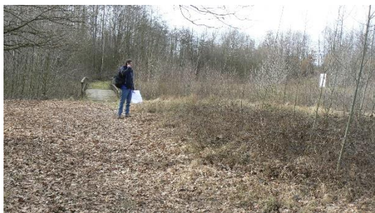
Figuur 16: Het westelijke bruggetje. Deze wordt voor het Rondje Groeves richting de plas verplaatst.
