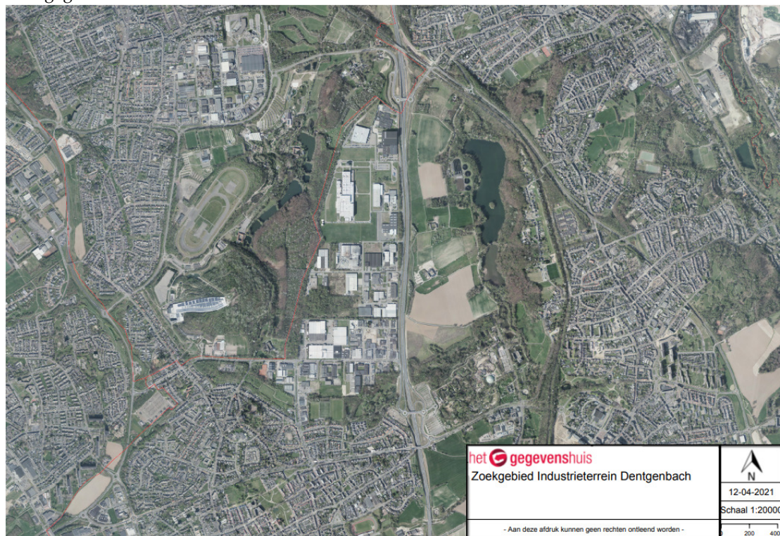
Luchtfoto Industrieterrein Dentgenbach.
