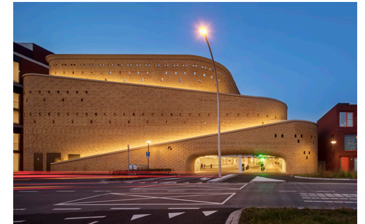
Parkeergarage Zwolle - Dok architecten
