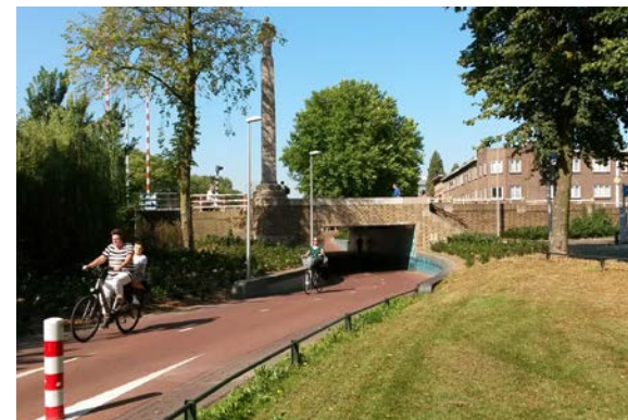
Nieuw toegevoegde fietsonderdoorgang Spinozabrug
