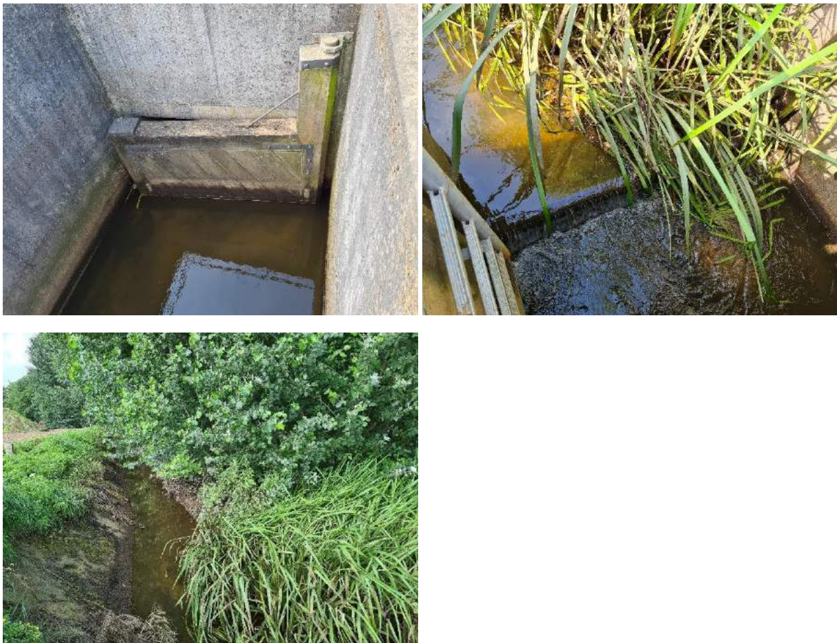
Figuur 3.1 Foto linksboven, draaideur net benedenstrooms van de dijk. Foto rechtsboven, vaste houten overlaat. Foto linksonder, strakke inrichting aan de bovenstroomse zijde
