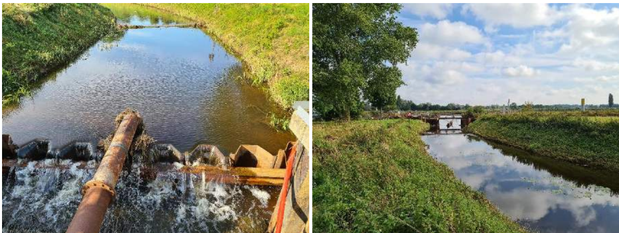
Figuur 2.1 Sambeekse uitwatering. Foto links, water stroomt over de damwand de Maas in. Pomp dient voor opmaling Maaswater tijdens droge perioden (water wordt richting Oeffeltse raam gepompt). Foto rechts, richting monding kijkend.
