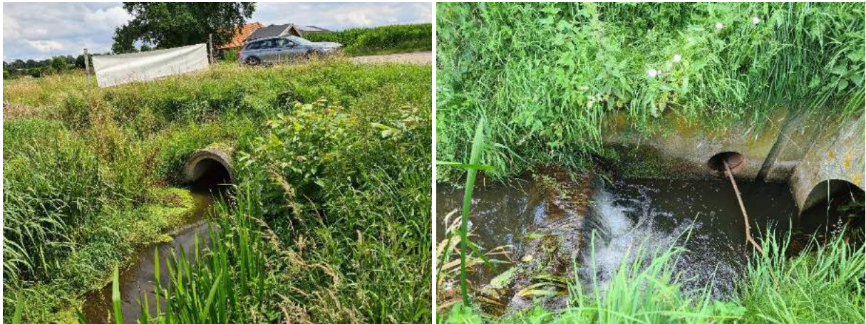
Figuur 10.1 Foto links, betonnen duiker vanaf benedenstroomse zijde gezien. Foto rechts, stuw 112A5 en betonnen duiker vanaf bovenstroomse zijde gezien.
