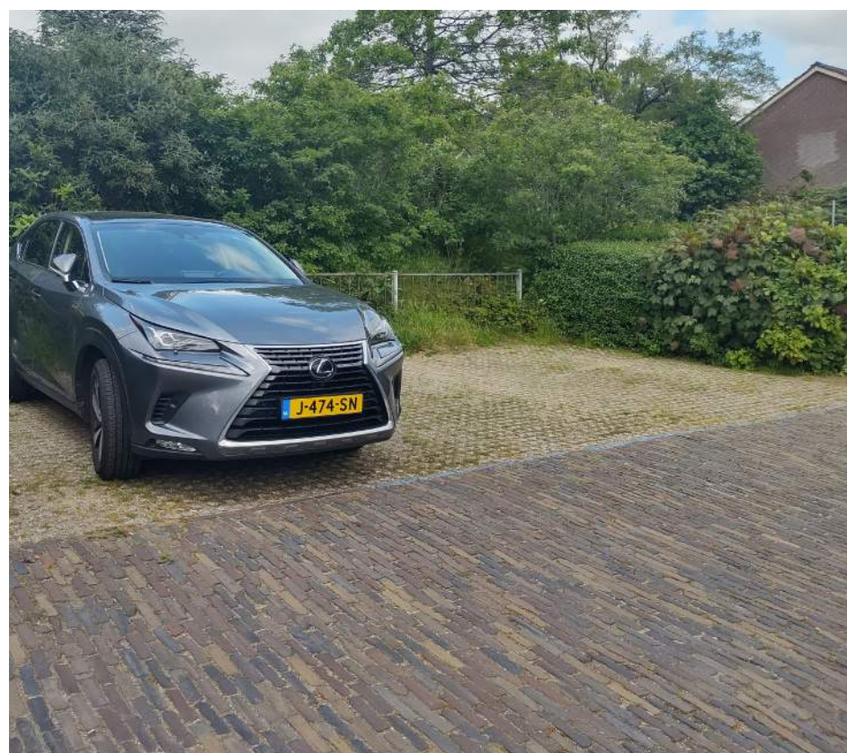
bestaande klinkers die goed hergebruikt kunnen worden
