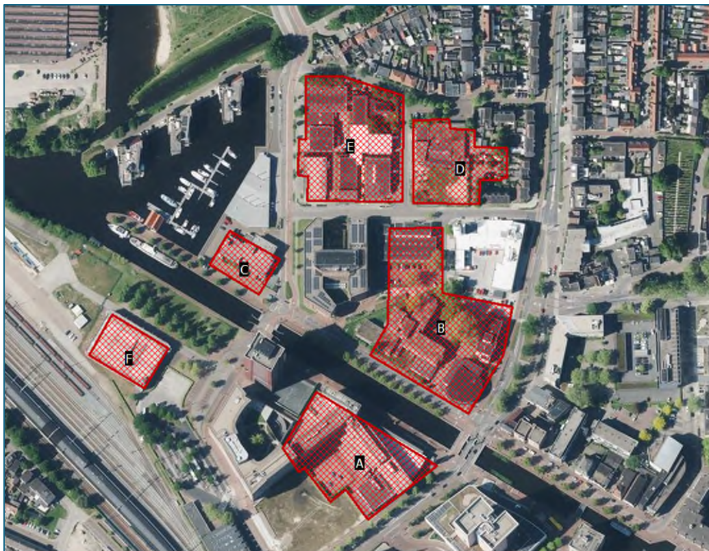
Figuur 3.1: Bouwblokken A t/m F Westerdok.
