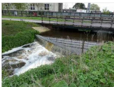
Figuur 2.6 Sluis in de Almelose Aa aan de oostzijde van de onderzoekslocatie.
