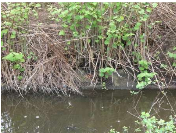
Figuur 4.5 Oevers gedeeltelijk bestaande uit beton.
