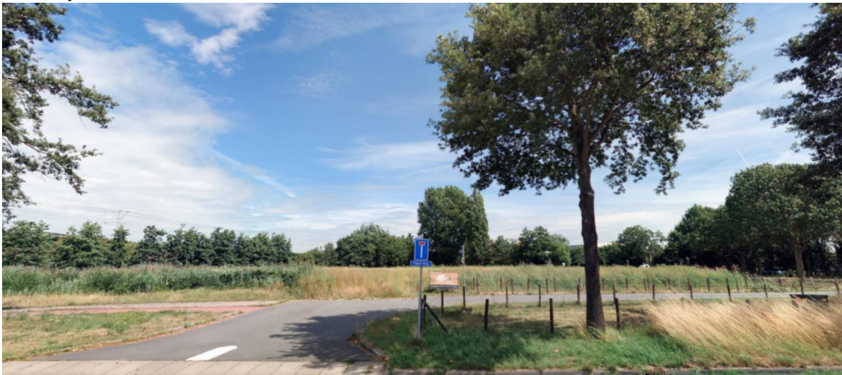
Zicht vanaf de Ruimtebaan op het plangebied. Op de foto is het dijklichaam van het baggerdepot te zien, net als de oprit naar het Conferencepad.
