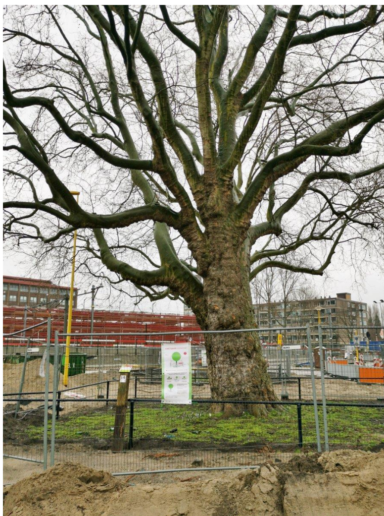
Bescherming boomkroon met bouwhekken
