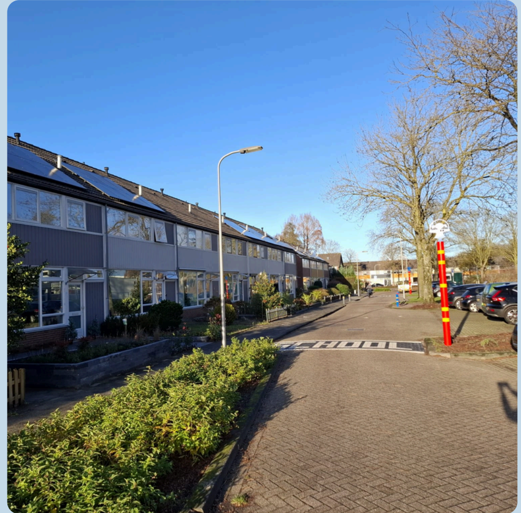
Locatie Esstraat Raalte
