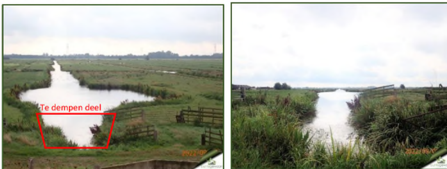
Figuur 9. Te dempen slootdeel, links vanaf dijkhoogte, rechts frontaal
