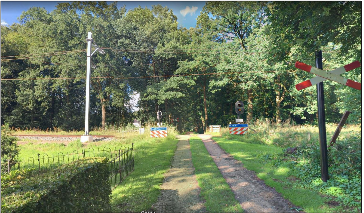
Figuur 2 Huidige situatie spoorwegovergang vanaf de zuidkant bekeken
