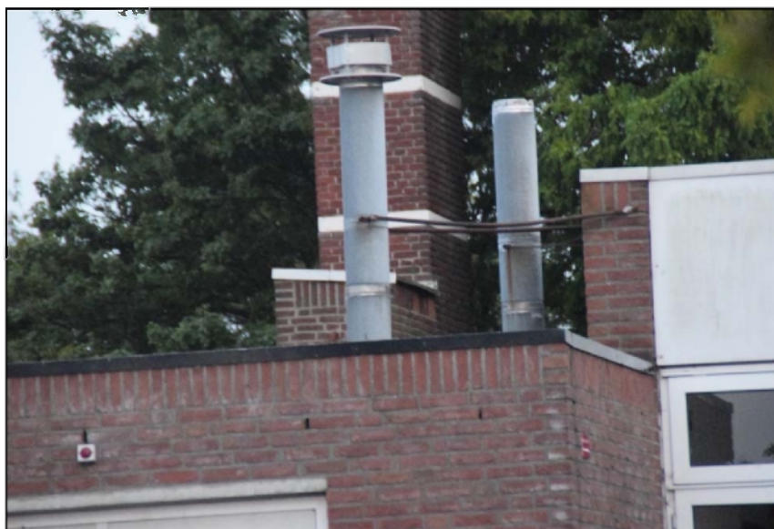
Spouwgaten in een muur van het lage deel van het gebouw. Deze gaten geven mogelijk toegang tot voor vleermuizen geschikte holtes.
