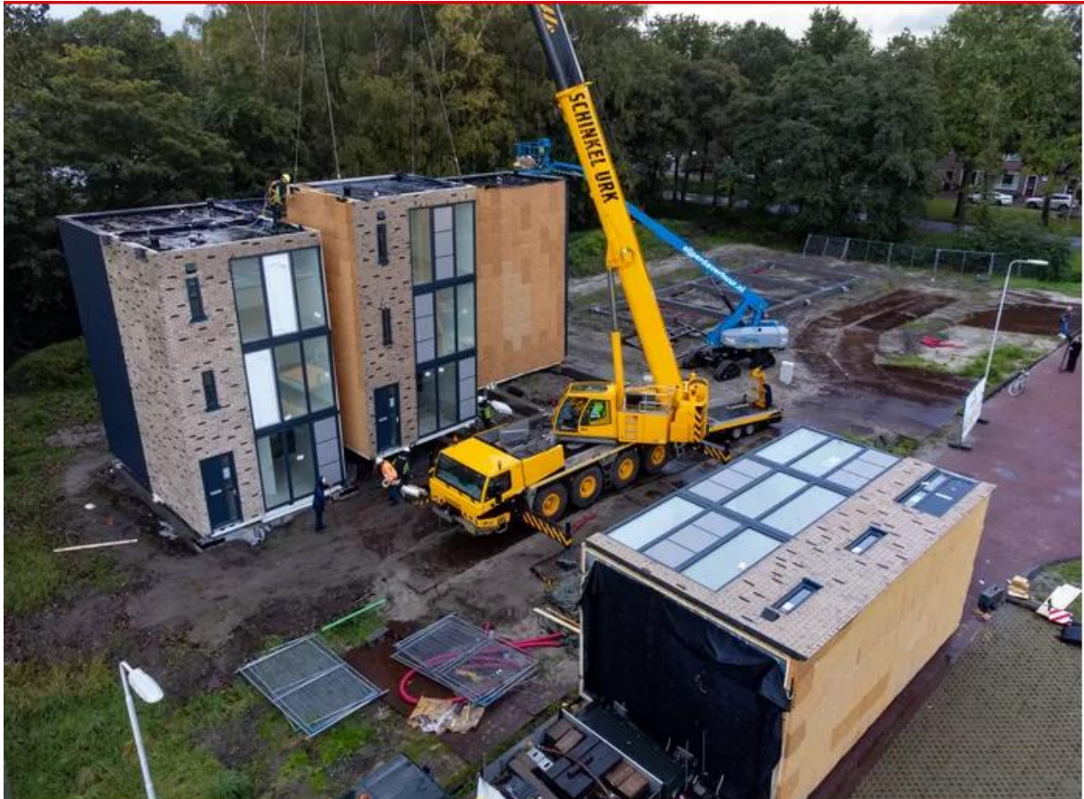
▲ Het plaatsen van vijfde StartBlock-huis aan de Meldestraat in Emmeloord. Nummer zes ligt rechts op de dieplader. © Foto Freddy Schinkel
