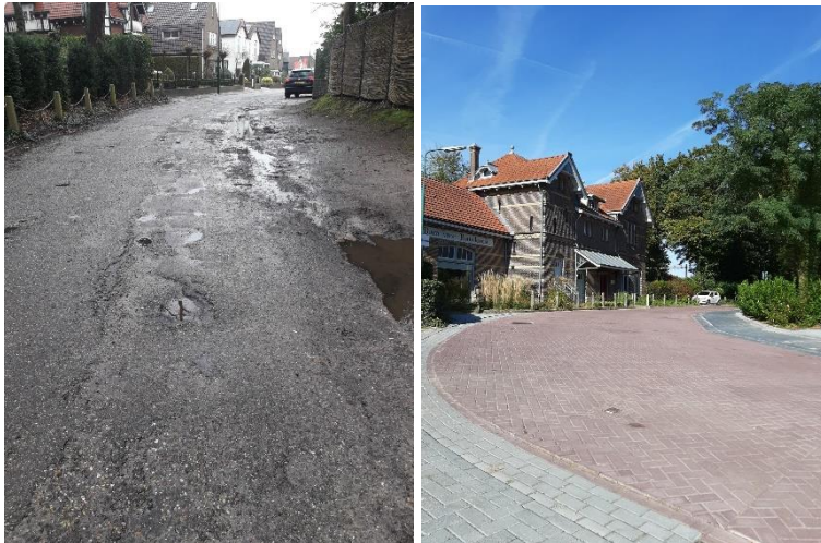
Foto 2 Integraal project Stationsweg
