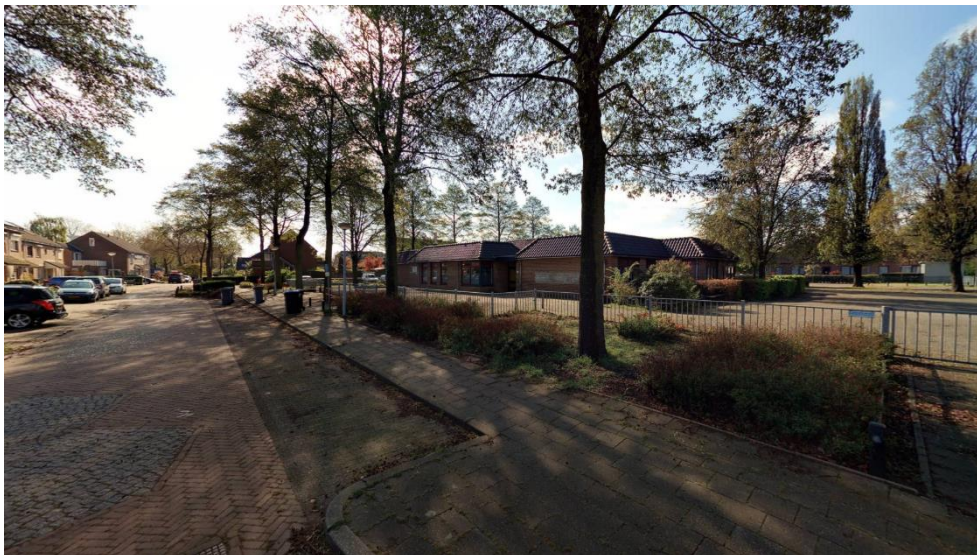
Figuur 1: De huidige bebouwing (foto Cyclomedia 2021)
