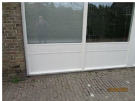
Asbest kozijnpanelen
