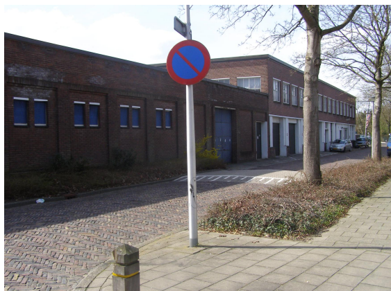
Foto's 5 en 6. Overzicht van enkele te slopen gebouwen langs de Boddenkampstraat en Joan Coststraat (situatie april 2010).
