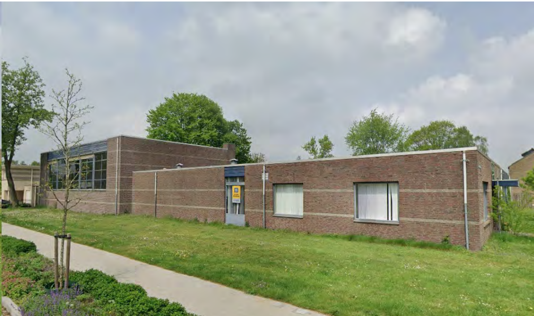
Figuur 2.3 Aanzicht deelgebied noord zuidzijde (Bron: Google Maps)
