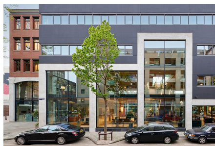
Een kantoorgebouw met aantrekkelijke plint die zich opent naar de straat (kantoorgebouw van Lieven de Key in Amsterdam)
