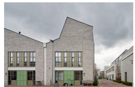
Atelierwoningen met ruimte voor werken aan huis (Beeldbuizenfabriek in Eindhoven, ontwerp: HilberinkBosch Architecten)
