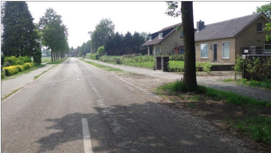
Foto 6: wegprofiel Graspeel ter hoogte van plangebied
