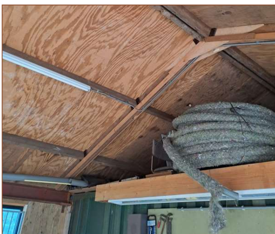
Afbeelding 2.5 en 2.6 – Toegang tot ruimtes achter de boeidelen, onder het dak en op zolder van de opslag is uitgesloten. Er zijn geen kieren en voor de afwerking zijn gladde materialen gebruikt, waardoor vleermuizen geen houvast hebben.
