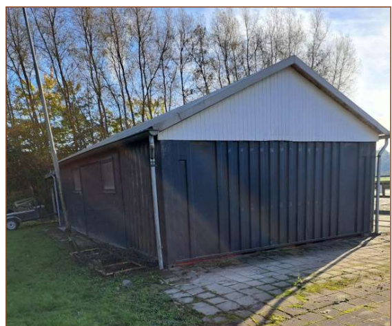
Afbeelding 2.5 en 2.6 – Toegang tot ruimtes achter de boeidelen, onder het dak en op zolder van de opslag is uitgesloten. Er zijn geen kieren en voor de afwerking zijn gladde materialen gebruikt, waardoor vleermuizen geen houvast hebben.
