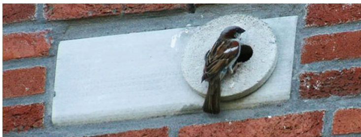
Voorzieningen van boven naar beneden: circulair bouwsysteem, zonneboiler, natuurvriendelijk ingerichte tuin, ingebouwde nestkast
